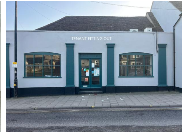
Tenant Fitting Out
